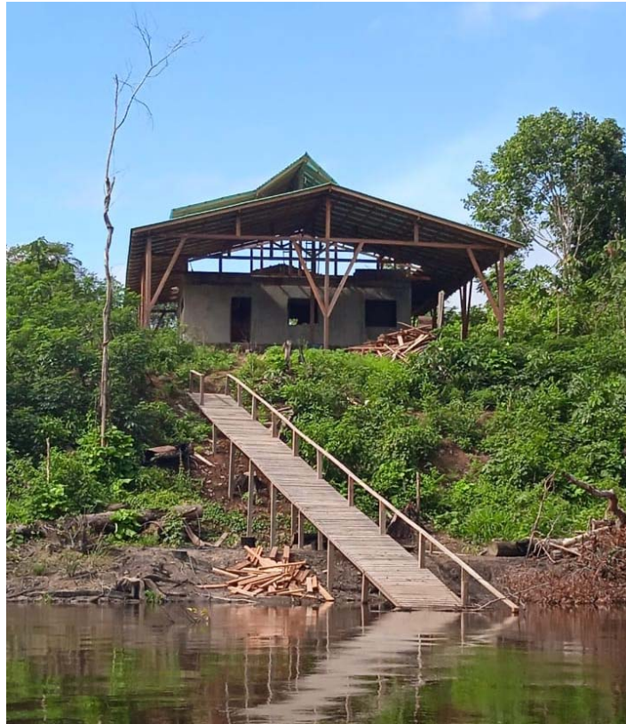
New office of Associação Sementeiras do Araguari under construction
