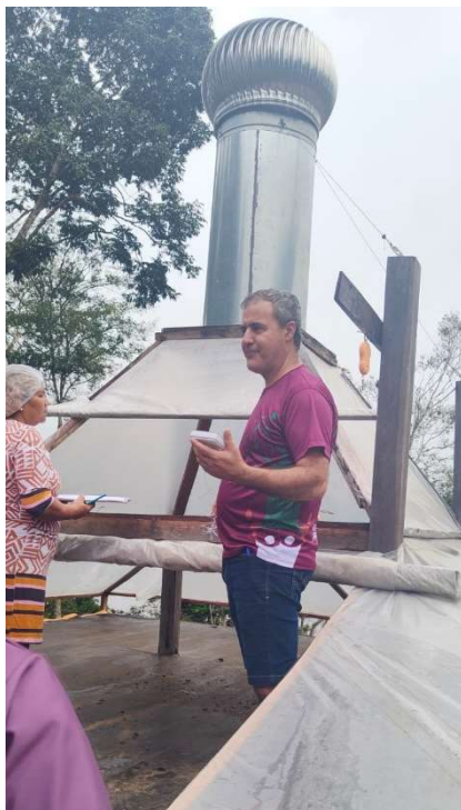
Installation of a solar dryer at Association Sementeiras do Araguari, Amapá. ©Embrapa
